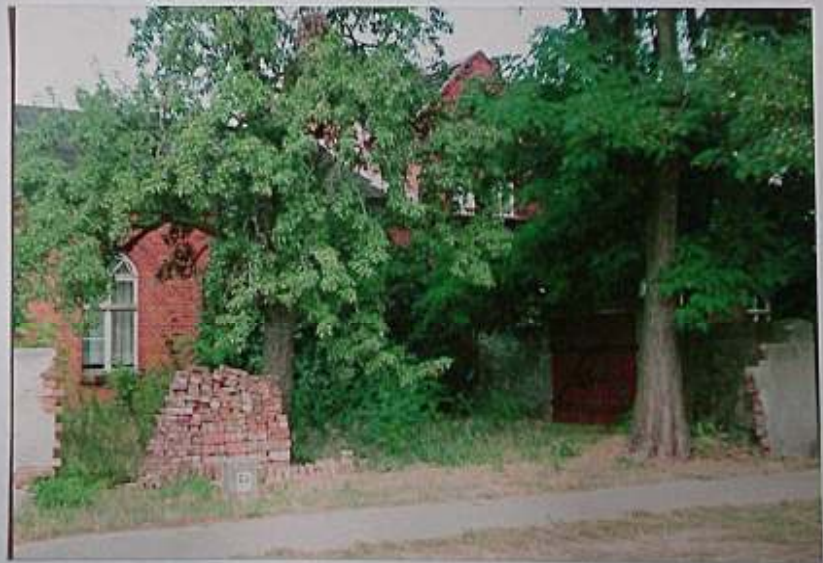
Blick auf den Saal der Gassäfte "Zum goldenen Adler"
