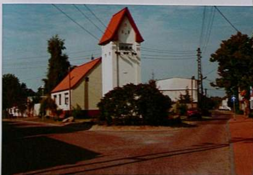
Fertiggestellte neue Dorfstraße und Woltersdorfer Straße Aufnahme 2002
